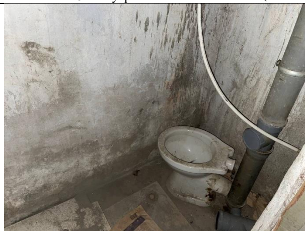
Фото № 18 – Внутреннее состояние помещения
