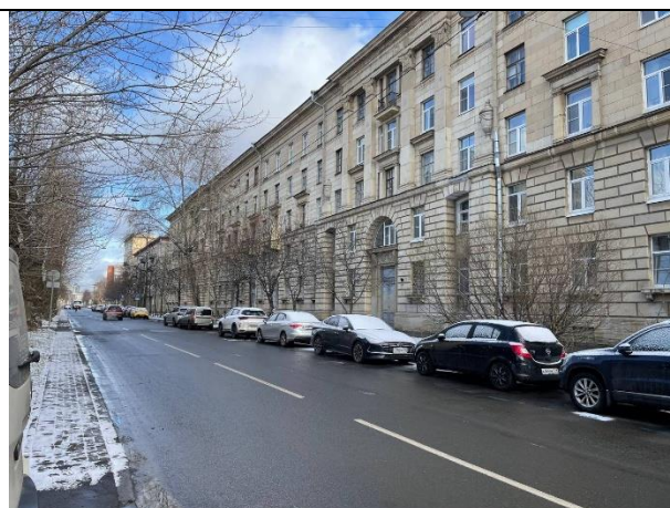
Фото № 2 – Подъездные пути
