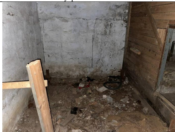
Фото № 22 – Внутреннее состояние помещения
