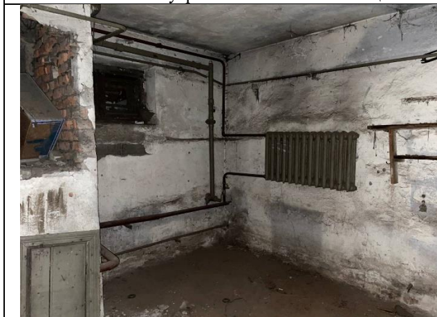
Фото № 21 – Внутреннее состояние помещения
