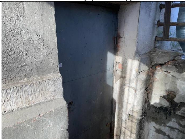
Фото № 9 – Вход в помещение
