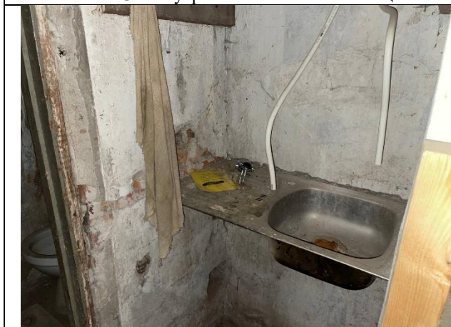
Фото № 17 – Внутреннее состояние помещения
