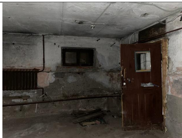
Фото № 16 – Внутреннее состояние помещения
