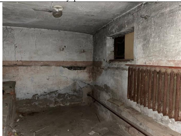
Фото № 14 – Внутреннее состояние помещения
