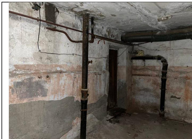
Фото № 15 – Внутреннее состояние помещения
