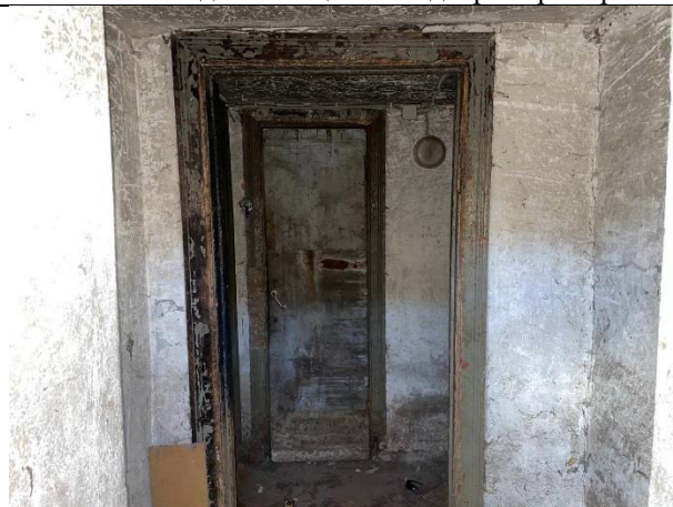
Фото № 10 – Внутреннее состояние помещения
