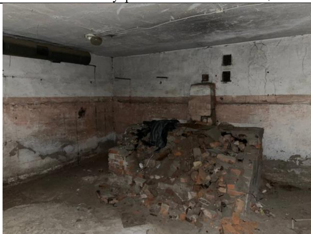
Фото № 13 – Внутреннее состояние помещения
